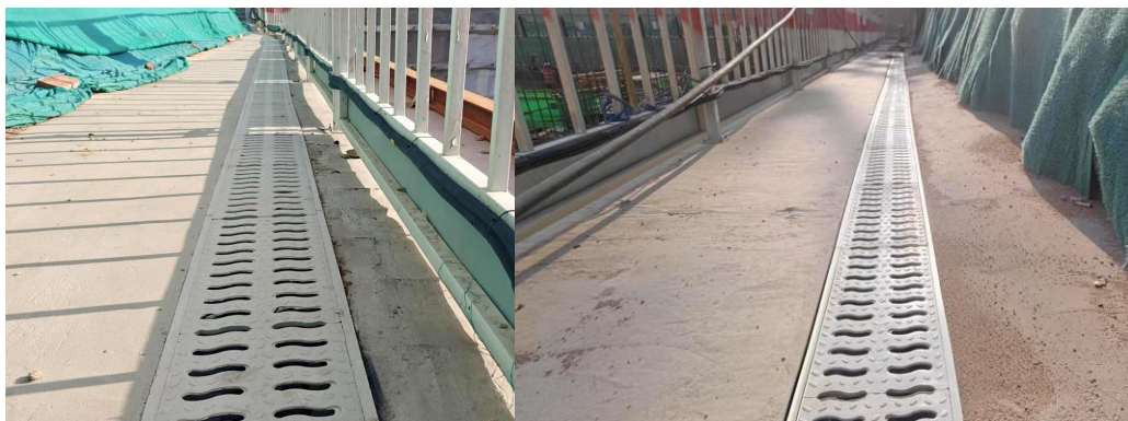
图 2-2 临时排水沟现场照片
