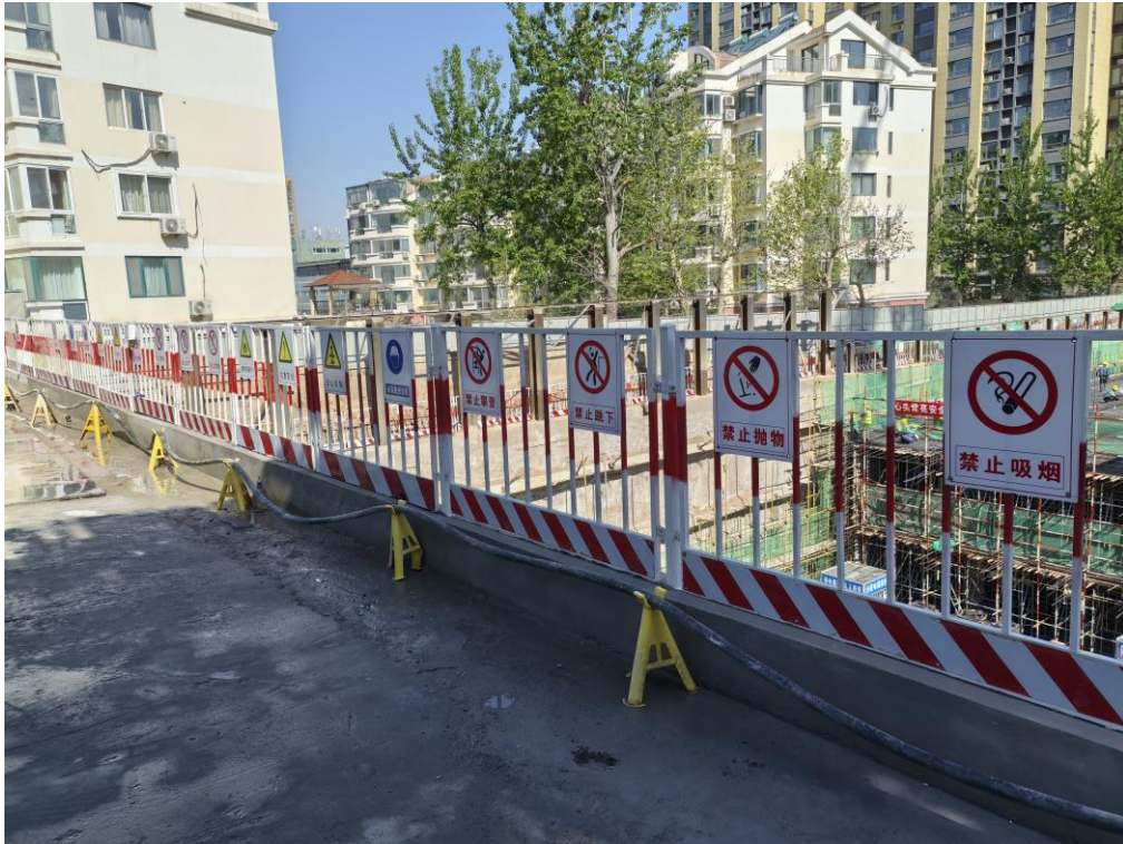
基坑挡水台及施工厂区（拍摄日期：2025 年 4 月）
