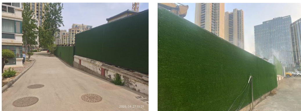
图 2-5 临时围挡现场照片
