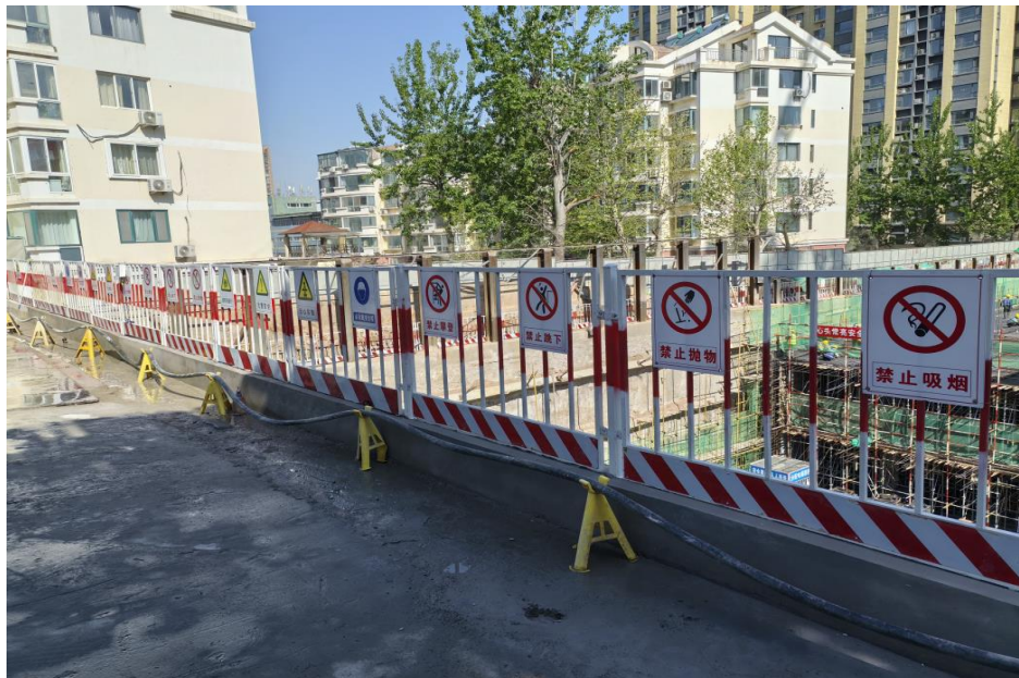
图 2-4 基坑挡水台现场照片
